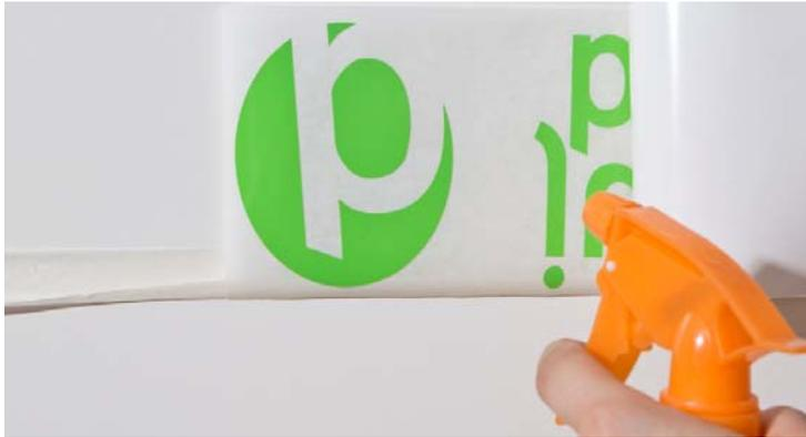
Die Kleberrückseite und den zu beklebenden Untergrund mit entspanntem Wasser besprühen.
