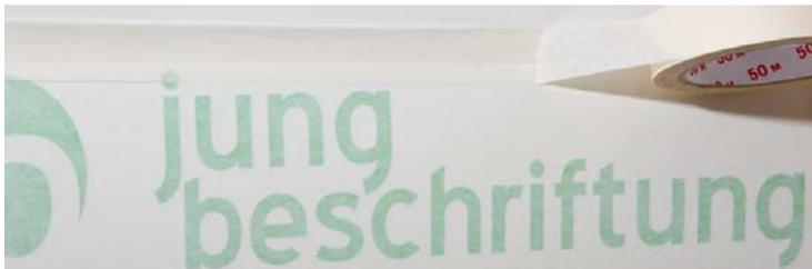
Ausgehend von dieser Hilfslinie, den Kleber mit Hilfe eines Massbandes genau positionieren und seitlich mit Abdeckband fixieren. Sobald der Kleber korrekt positioniert ist, an der oberen Kante Kleber mit Abdeckband so befestigen, dass das Abdeckband nicht übersteht. Danach die seitlichen Montagebänder entfernen.
